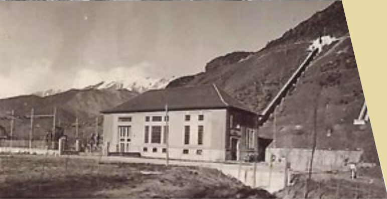
◀ La central de Vilaller, Alta Ribagorça, construïda per ENHER i en funcionament des del 1952 (Fondo Histórico de Endesa) La central del Vilaller, Alta Ribagorça construïda por ENHER y en funcionamiento desde 1952
