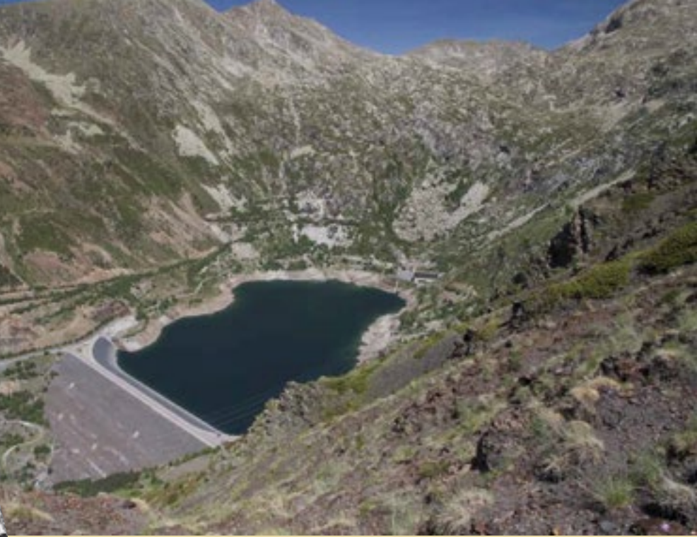
◀ Construcció de la presa de l'embassament d'Escalles, Alta Ribagorça, per l'empresa ENHER (any 1954) (Fondo Histórico de Endesa) Construcción de la presa del embalse de Escalles, Alta Ribagorça por la empresa ENHER (año 1945)
