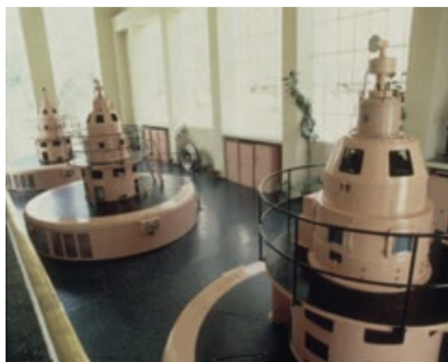
Interior de la central d'Esterrí d'Àneu (Pallars Sobirà), construïda per HECSA i en funcionament des del 1958 (FECSA)
