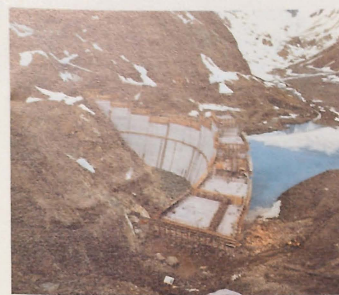
presa de Llauset. En construcción (30.5.1983)
