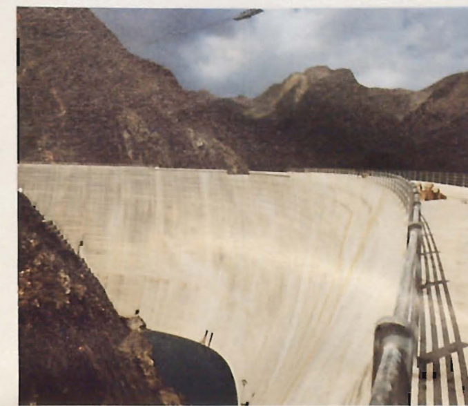
presa de Llauset
