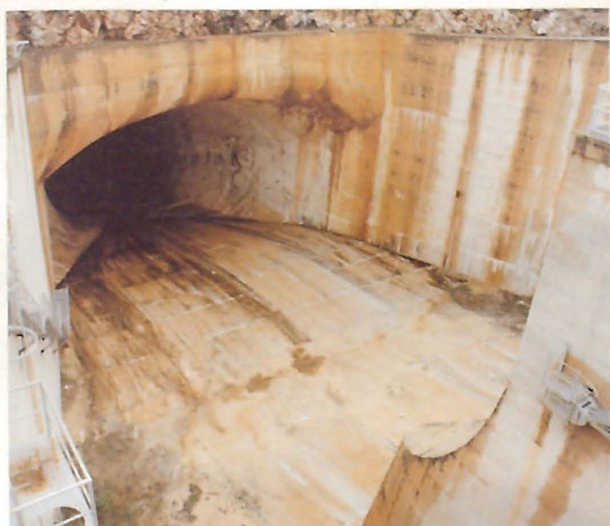
Emboquille túnel de descarga
