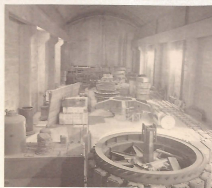
Central en construcción
