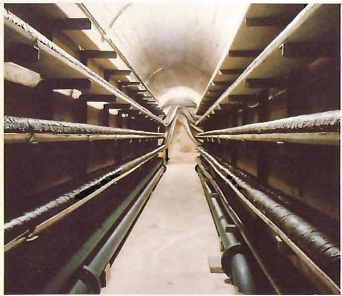
Galería de cables
