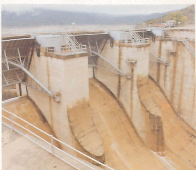
Aliviadero de superficie
