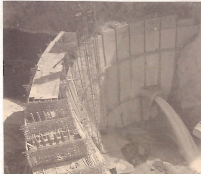
Presa en construcción
